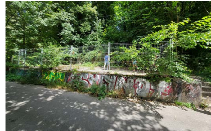
ABBILDUNG 2: BETONFUNDAMENT UND TREPPE
